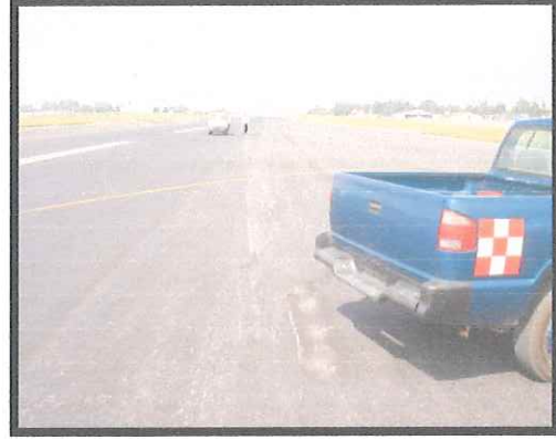
Fotografía No. 14 Vista 3 de marcas en la pista
