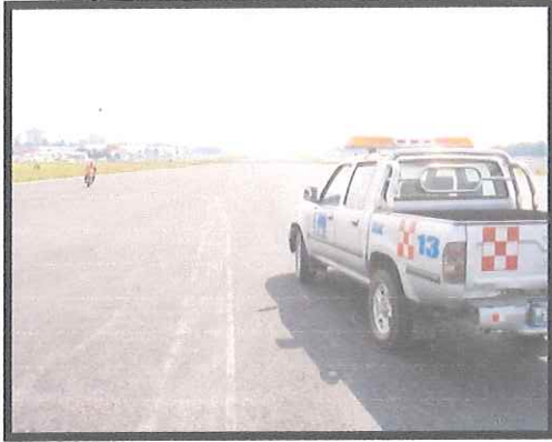
Fotografía No. 13 Vista 2 de marcas en la pista
